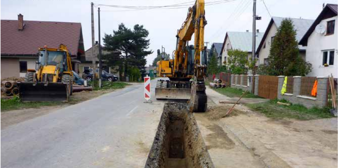
Výkop ryhy v štátnej ceste I. tr. v obci Rabča. Pokládka kameninového potrubia v telese cesty.
