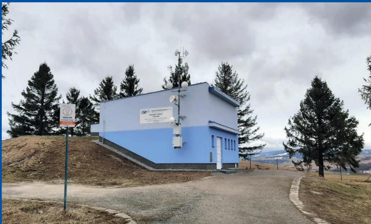
Zrekonštruovaný vodojem 1x250 m 3 Trstená
