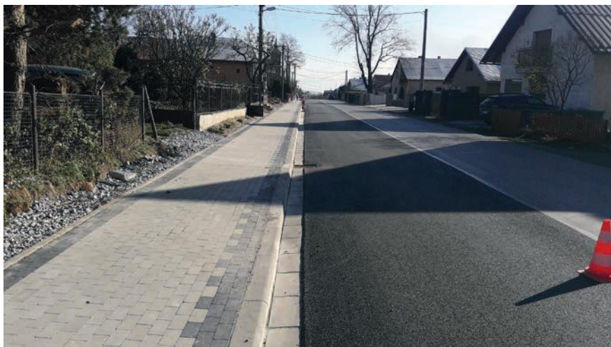
Oprava vady konečnej úpravy štátnej cesty I/78 v obci Oravská Polhora v rámci projektu „Orava II.“
