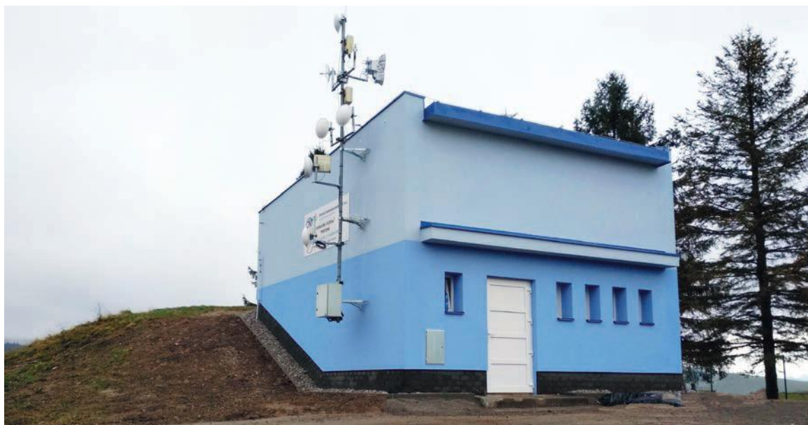
Zrekonštruovaný vodojem 1x250 m 3 Trstená
