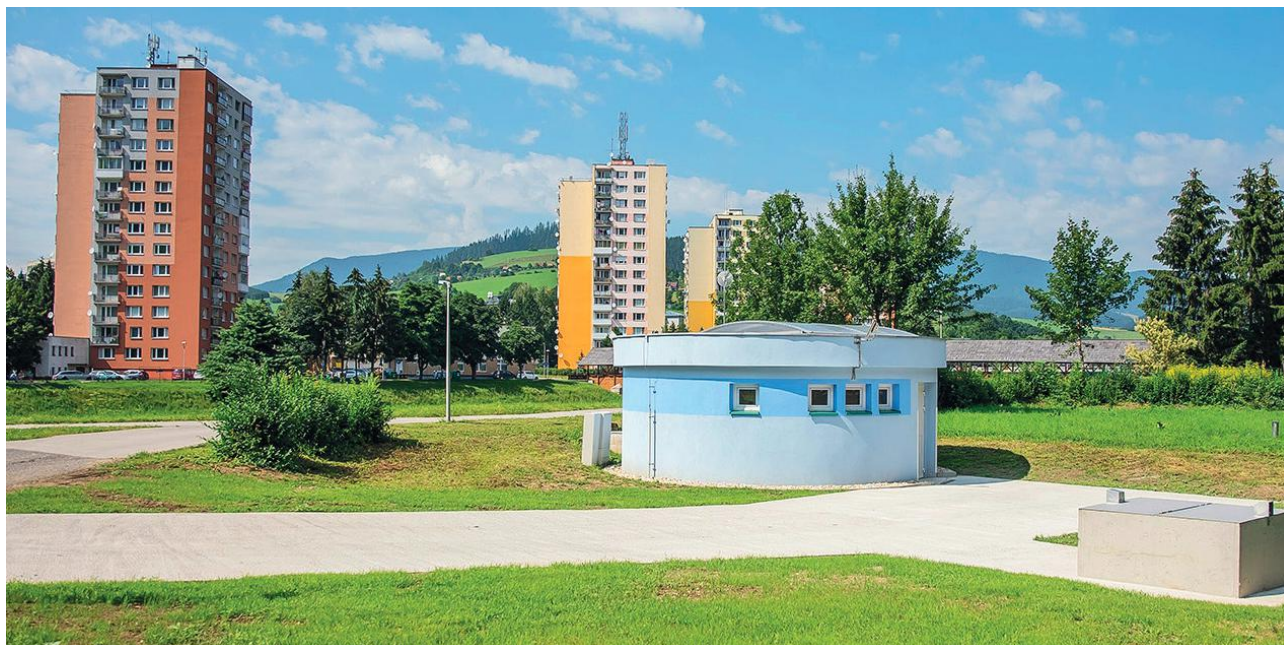
Dolný Kubín – rekonštrukcia čerpacej stanice odpadových vôd – ČS Staré Mesto
