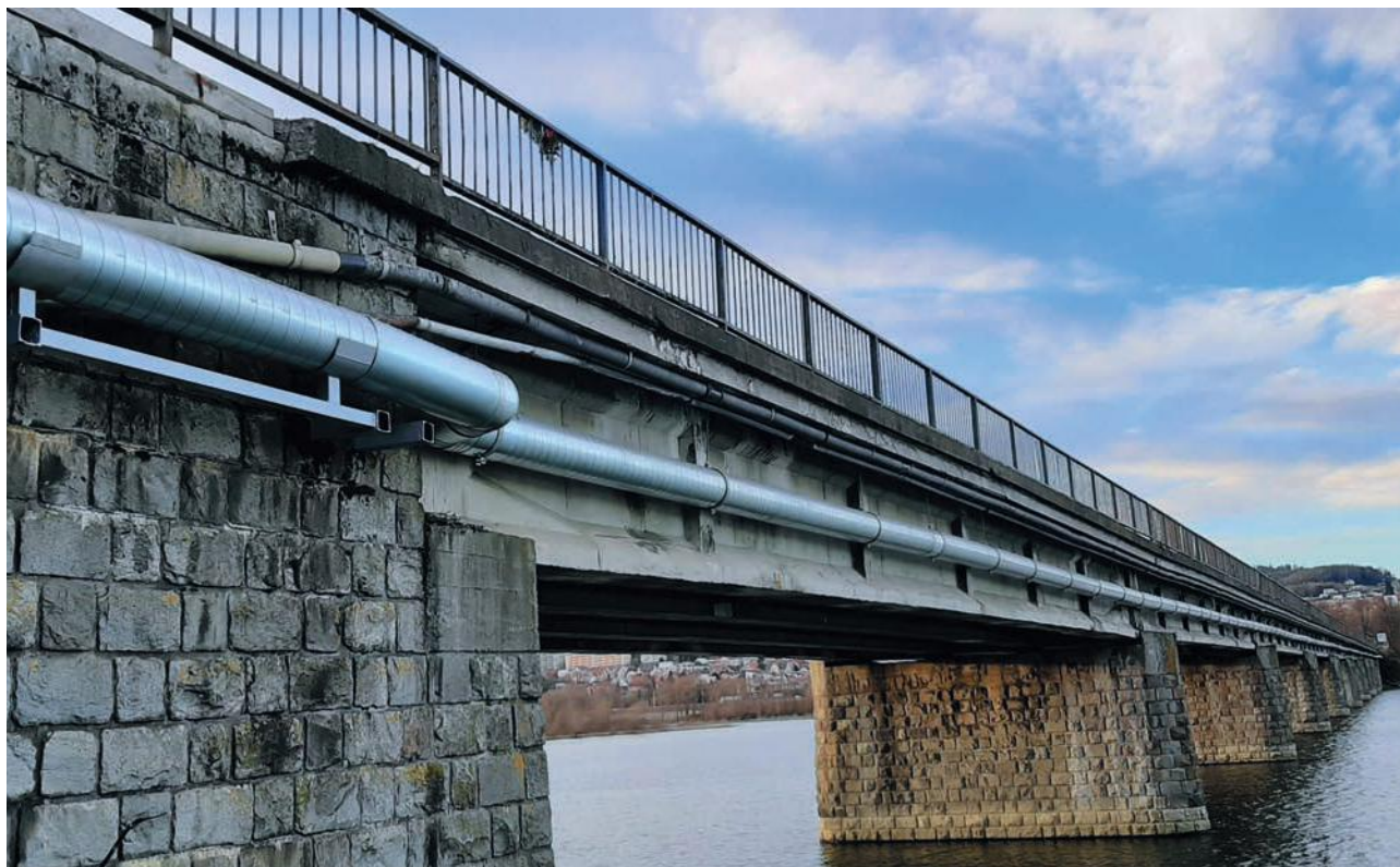
Námestovo – most št. cesta III/2273 - oprava vodovodného potrubia OC DN 250
