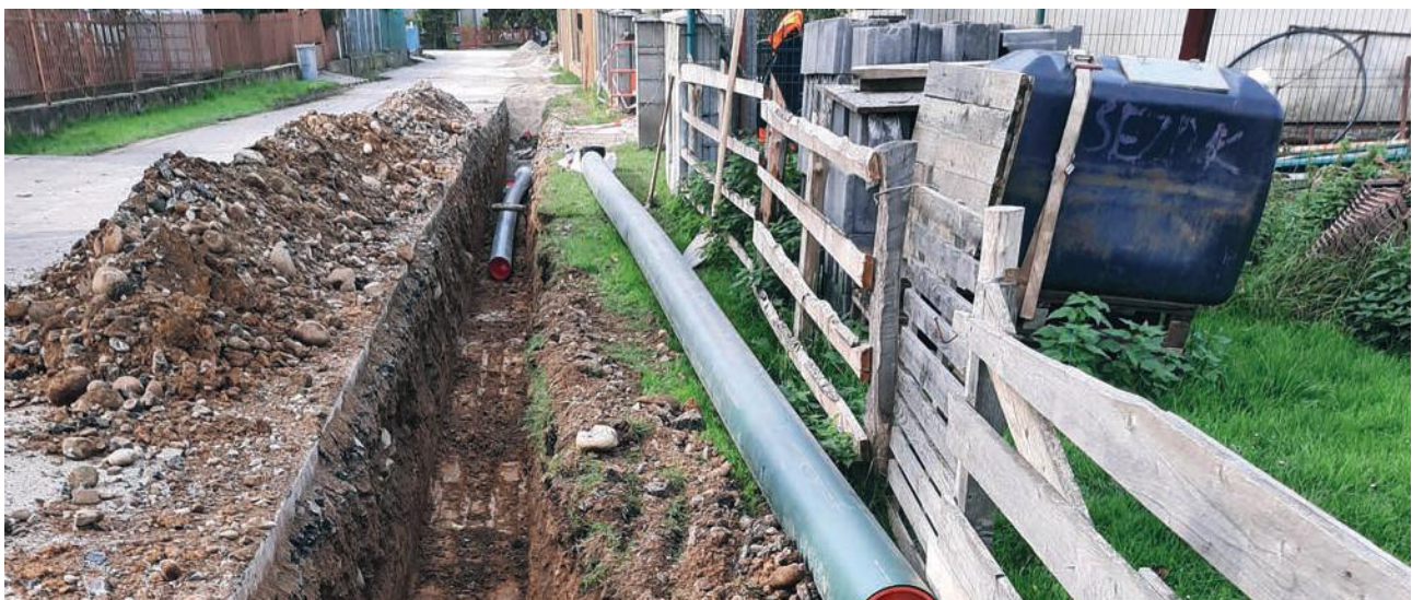
Výstavba kanalizačného výtlačného potrubia v obci Oravská Poruba
