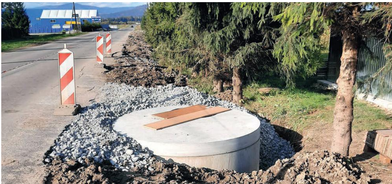
Dokončenie zberača Liesek - Trstená v rozdeľovacej šachte
