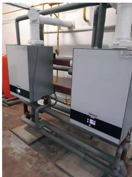
Výmena plynových kotlov v kotolni administratívnej budovy
