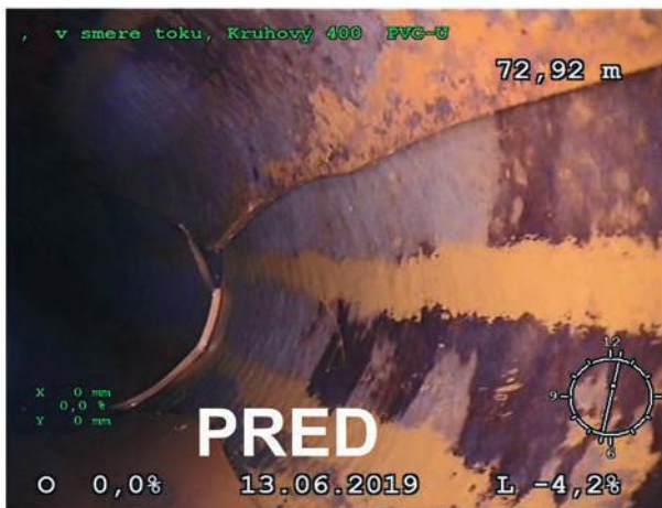
Námestovo, ul. Plátenicka – bezvýkopová oprava verejnej kanalizácie. Stav pred a po oprave
