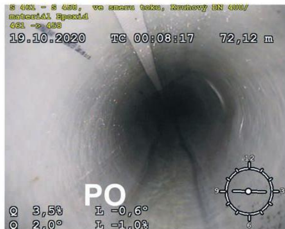
Námestovo, ul. Plátenicka – bezvýkopová oprava verejnej kanalizácie. Stav pred a po oprave
