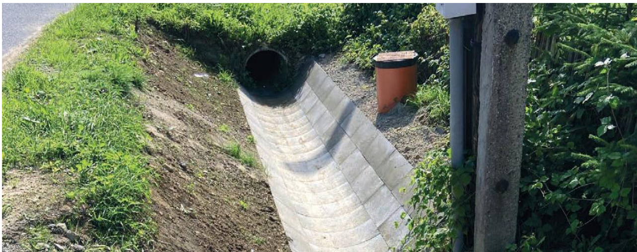
Nadalej prebiehajú opravné práce na projekte „Orava II“. Oprava cestného rigolu popri štátnej ceste I/78 v obci Oravská Polhora.
