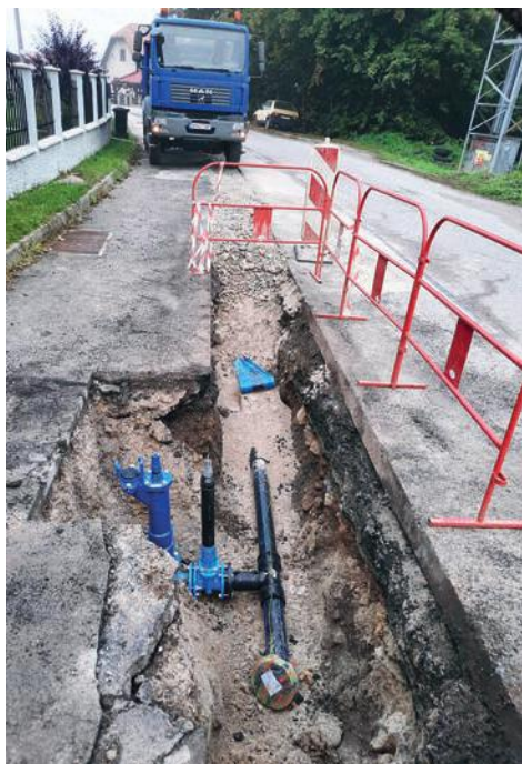
Rekonštrukcia vodovodu v obci Osádka.
