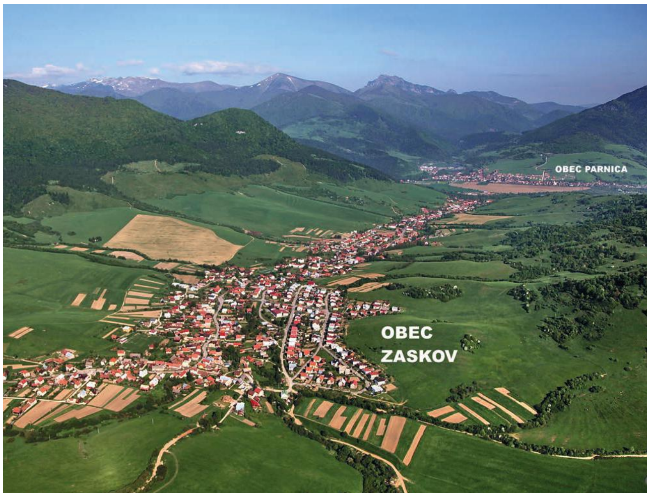
Odkanalizovanie obcí dolnej Oravy – Žaškov, Párnica, Oravská Poruba, Veličná v obciach Žaškov a Párnica. Stavba je spolufinancovaná z fondov EÚ a SR v rámci operačného programu OP KŽP. Realizácia stavby začala 21. 12. 2021.
