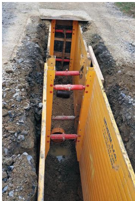
V roku 2021 bola zahájená stavba verejnej kanalizácie v obci Breza v rámci operačného programu IROP.
