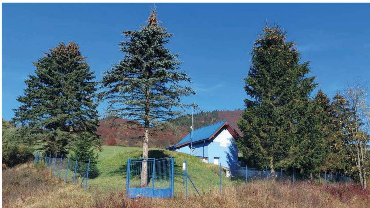
Vodojem 2x250 m 3 v obci Dlhá nad Oravou
