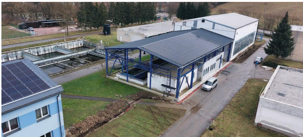
Z dôvodu vysokých cien energií a riešenia energetických úspor bola v zmysle investičného plánu 2022 inštalovaná fotovoltaická elektrárňa na ČOV Dolný Kubín
