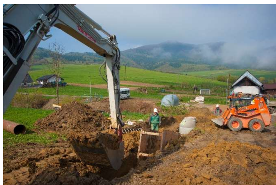
Obr. 3: Hĺbenie ryhy pre uloženie kanalizačného potrubia a osadenie potrebného pažiacej konštrukcie v obci Žaškov (SS.01)
