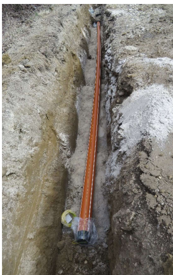
Obr. 7: Stavebné práce - kanalizačný zberač SS.05: polozenie výtlačného potrubia, osadená vzdušnikovú šachta, vybavenie vzdušnikovej šachty
