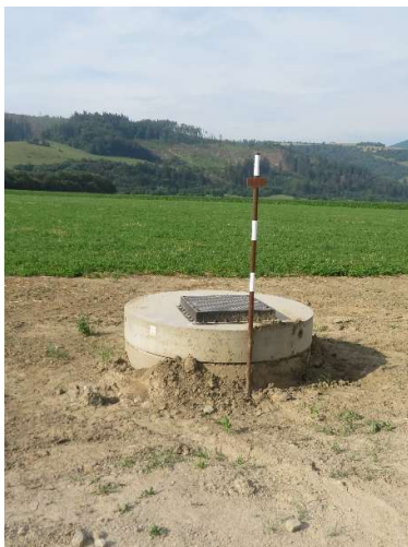
Obr. 7: Stavebné práce - kanalizačný zberač SS.05: polozenie výtlačného potrubia, osadená vzdušnikovú šachta, vybavenie vzdušnikovej šachty
