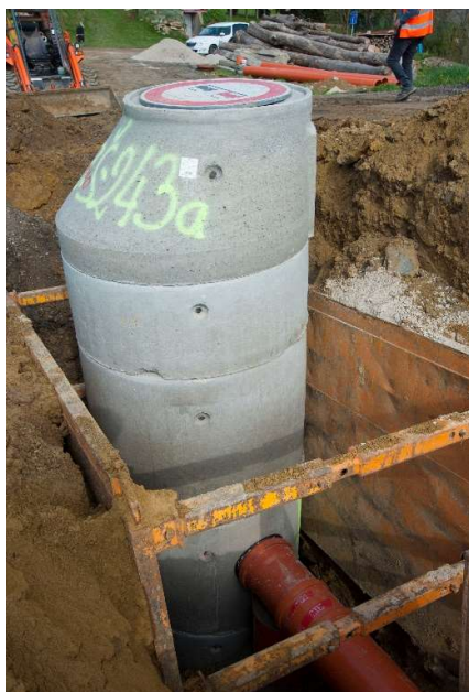
Obr. 2: Osadenie kanalizačnej šachty v obci Žaškov (SS.01)
