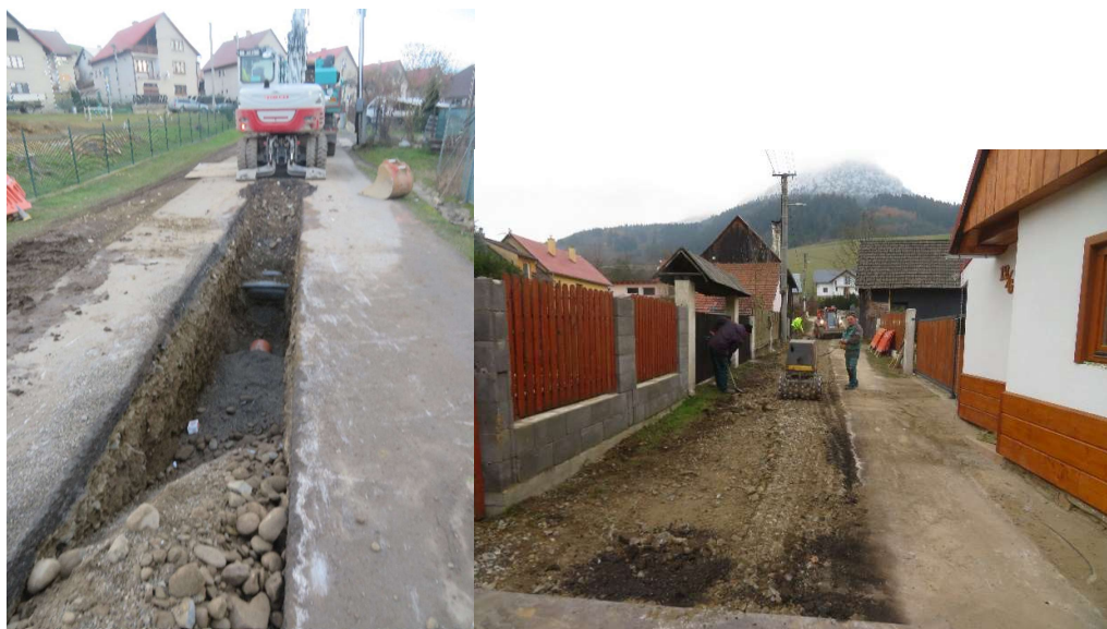
Obr. 2: Budovanie kanalizácie - stavebné práce v miestnej komunikácii v obci Žaškov (SS.01)
