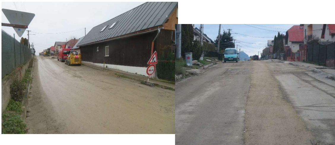
Obr.4: Úprava miestnych komunikácií v obci Párnica (SS.02)
