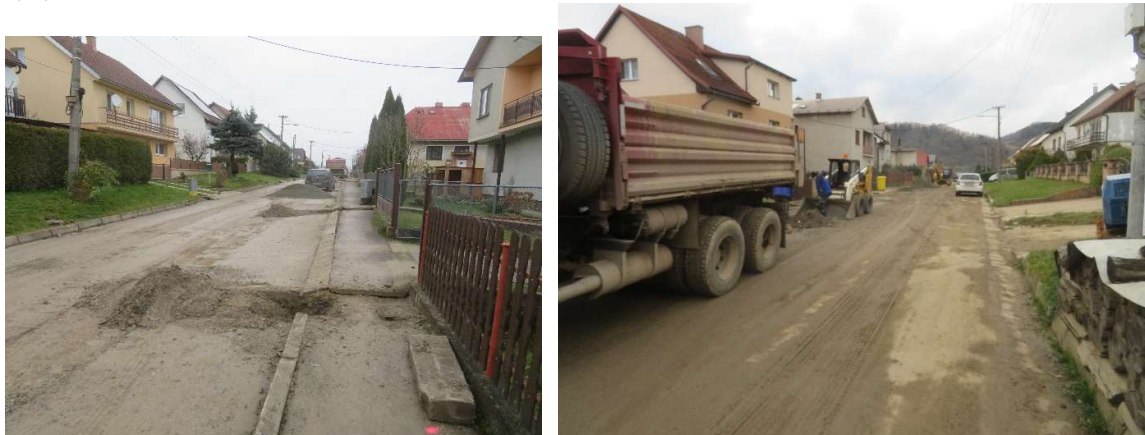
Obr. 3 Budovanie kanalizačných prípojení v obci Párnica (SS.02)
