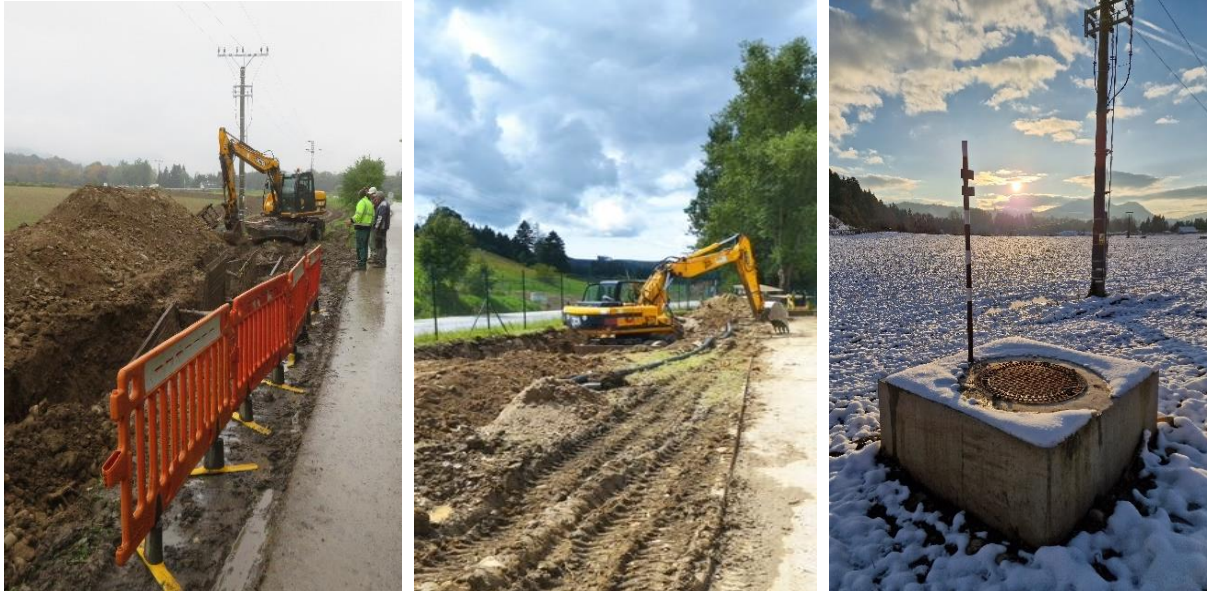
Obr. 8: Výstavba kanalizačného potrubia v k.ú Poruba-Gecel' (SS.07)
