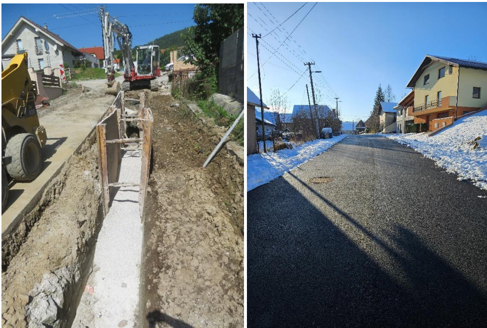
Obr. 5 Budovanie verejnej kanalizácie a konečné úpravy komunikácií v obci Párnica (SS.02)
